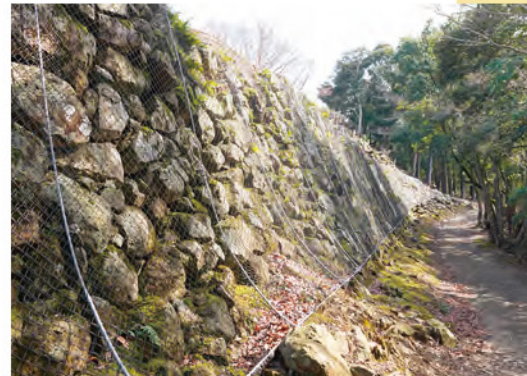
有子山城(豊岡市)は秀長の命により、石垣の城へと改修された
